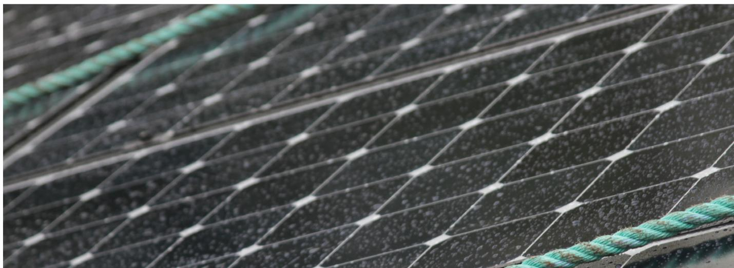
**注意：**请勿在炎热天气清洗电池板。这样做可能损坏电池板。冲洗太阳能电池板会造成屋顶湿滑。请从地面用水管冲洗电池板，避免站在屋顶上。切勿在电池板上行走，因为这会损坏它们。
